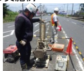
(貫入試験による調査)
