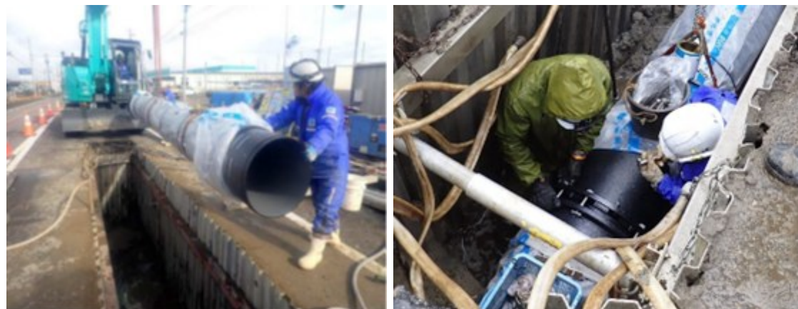
耐震管の布設工事
