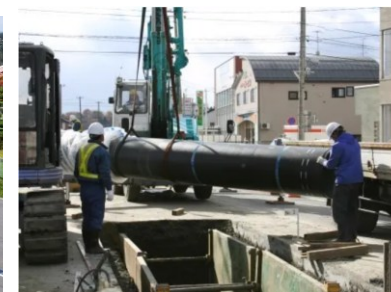
耐震管の布設工事
