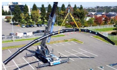
耐震型ダクタイル鉄管採用50周年セミナー (新耐震管GXφ500吊り上げ)
