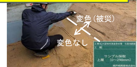
洗浄後(ろ過砂への赤土の混入)
