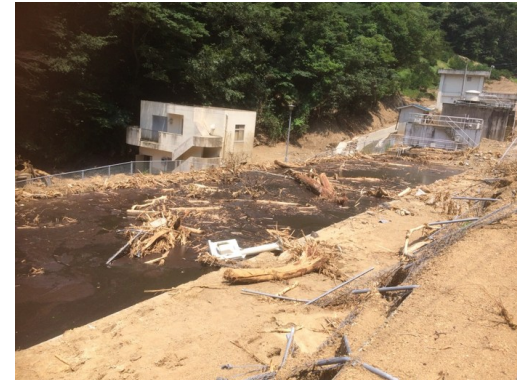
被害を受けた吉田浄水場
