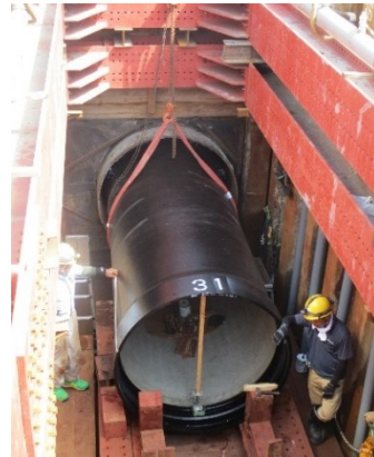
水道管路の更新イメージ
