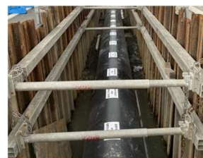
耐震管の布設
