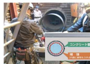
例：管路の耐震補強
