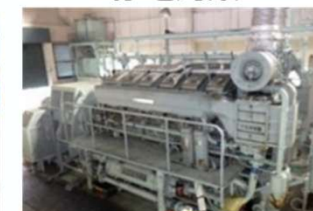
例：自家用発電機の整備
