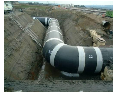
大径埋設管の施工例
