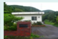
簡易水道施設
