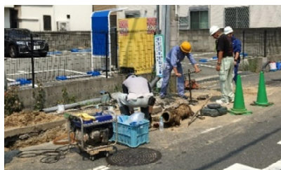
断通水作業状況
