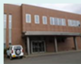
赤川高区浄水場
