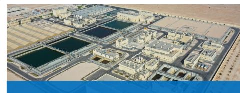
アル・ダキーラ下水処理場
