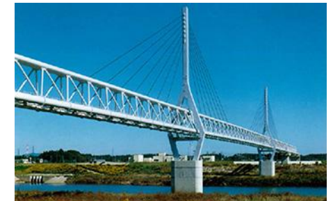
水管橋の施工例
