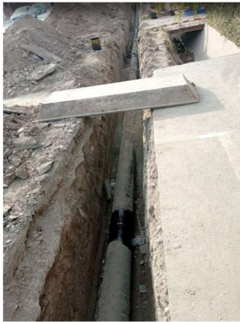
水道管は雨水排水路（写真右側）と車道の間の歩道下に敷設
