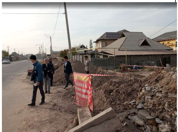
工事路線の現地状況
