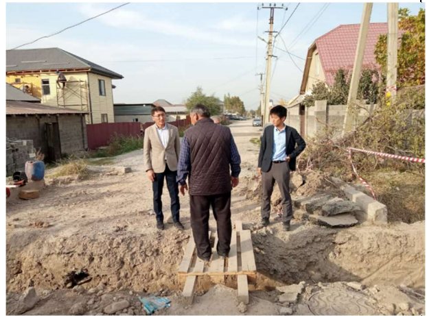
施工現場の担当者から、説明を受ける
