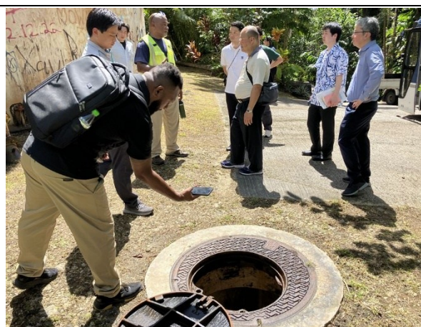
流量計用マンホール
