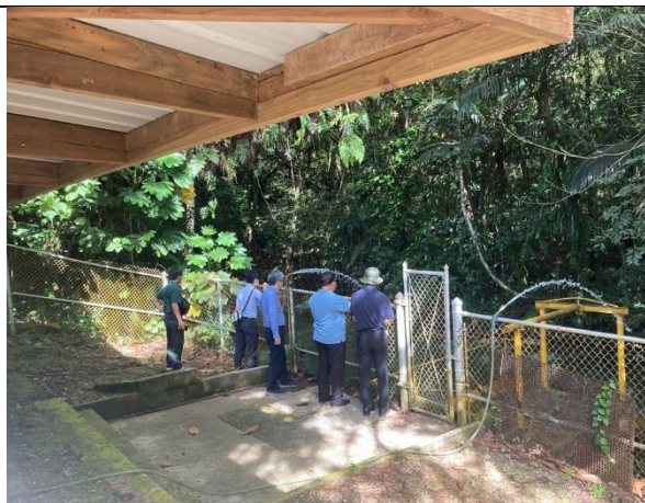
取水施設外観
