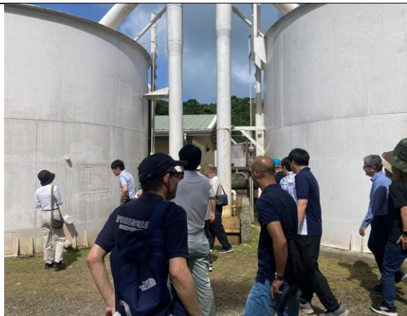
重力式ろ過タンク
