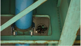
狭小部の撮影状況(橋梁添架管)
