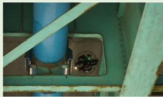
狭小部の撮影状況(橋梁添架管)
