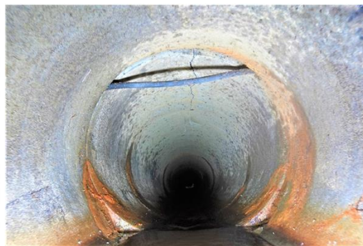
ドローンによる調査（飛行式カメラ）
