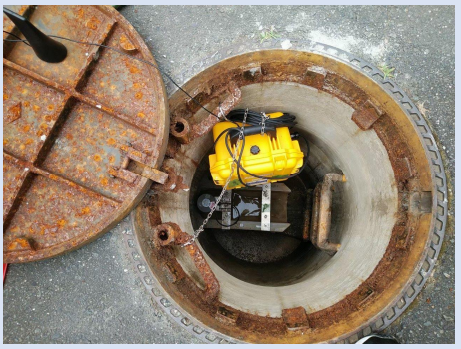
マンホール内流量監視
