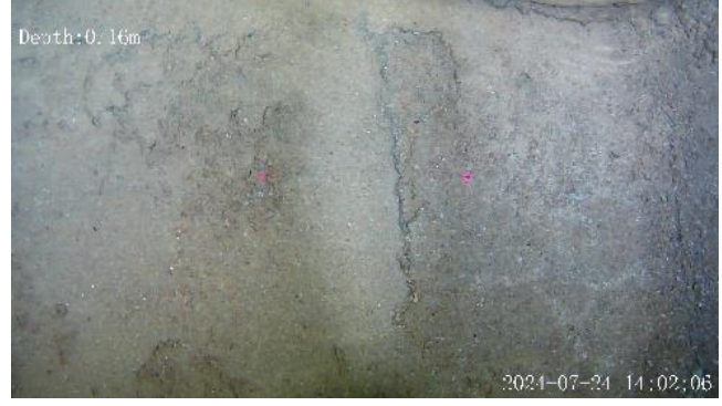
・天井露筋状況
