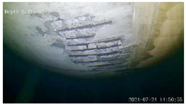
・天井露筋状況
