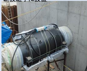
新設継手に設置
