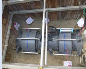
耐震補強継手に設置
