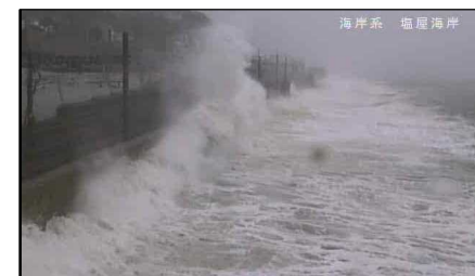
平成30年台風第21号 垂水工区
