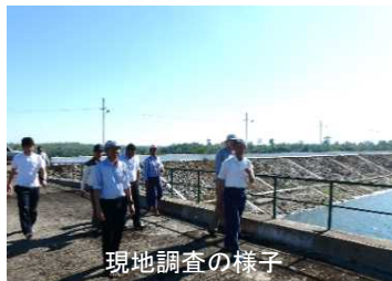
現地調査の様子
