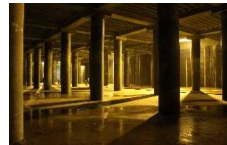
貯留施設の整備
