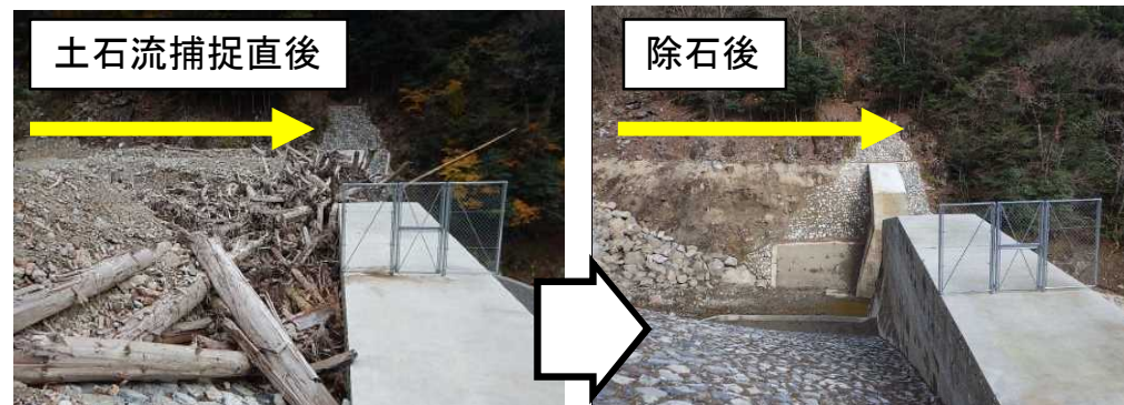
砂防堰堤の除石事例
