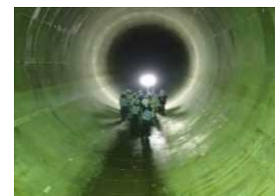
雨水貯留管の整備
