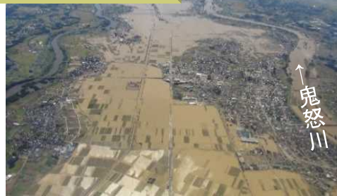
【H27.9 関東・東北豪雨】 (茨城県常総市)
