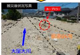
土砂・洪水氾濫による被害（H30.7豪雨）
