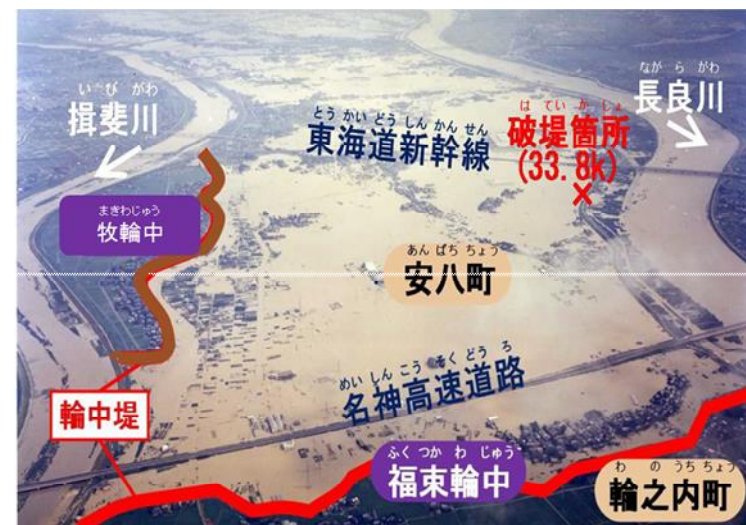
輪中堤:昭和51年9月台風17号の際の様子
