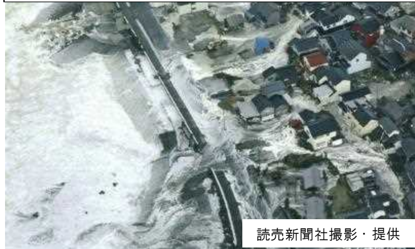
平成20年2月24日被災状況（富山県下新川海岸） しもにいかわ
