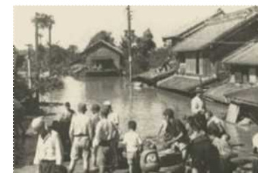
氾濫状況(埼玉県久喜市)
