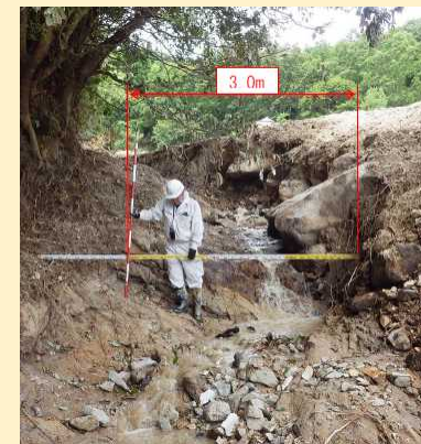
砂防事業における現地調査
