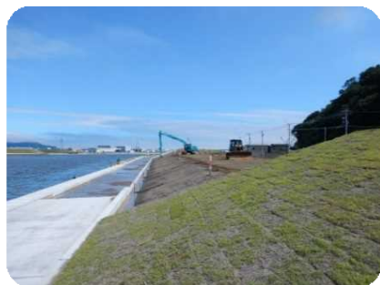
かどのわきよう 石巻市門脇町地区の堤防整備状況
