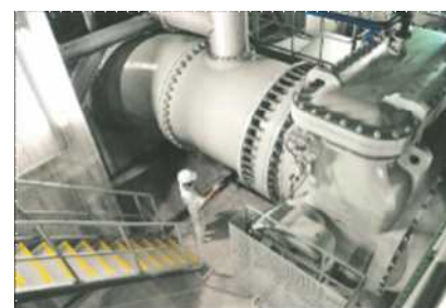
雨水ポンプの整備
