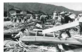
昭和36年洪水 かみしひむら 旧上志比村の被災状況
