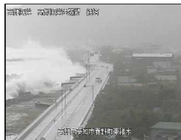
平成30年9月30日 戸原工区
