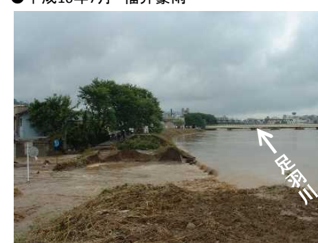
堤防の決壊状況(福井市春日)
