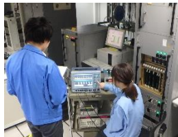
（航空保安施設点検実施状況）
