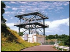
遠隔対空通信施設
