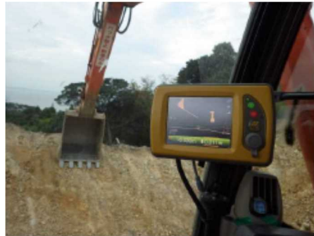
図10 「ハイテク」で「スマート」 な建設現場のイメージ ～ICT 建機による法面整形～
