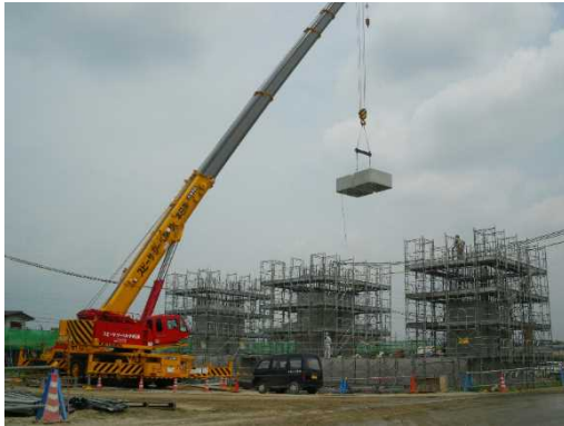
橋脚の施工状況
