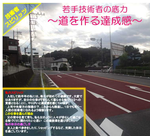
出典：国土交通省 関東地方整備局 HP
