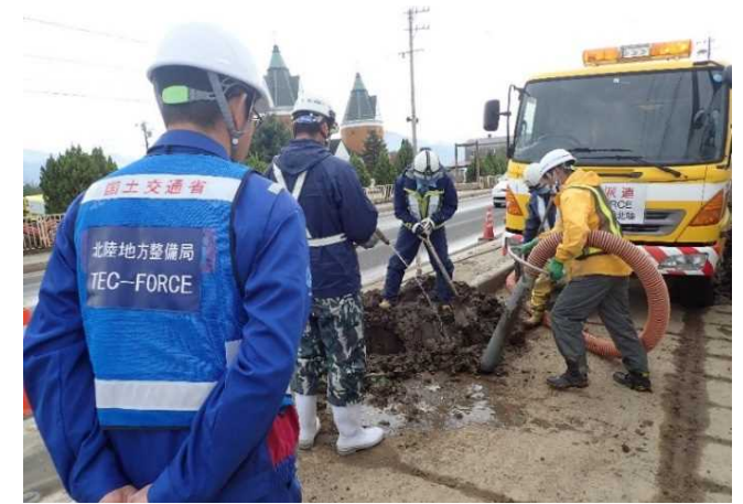
10月24日 長野県長野市における 路面清掃作業【北陸地整・応急対策班】
