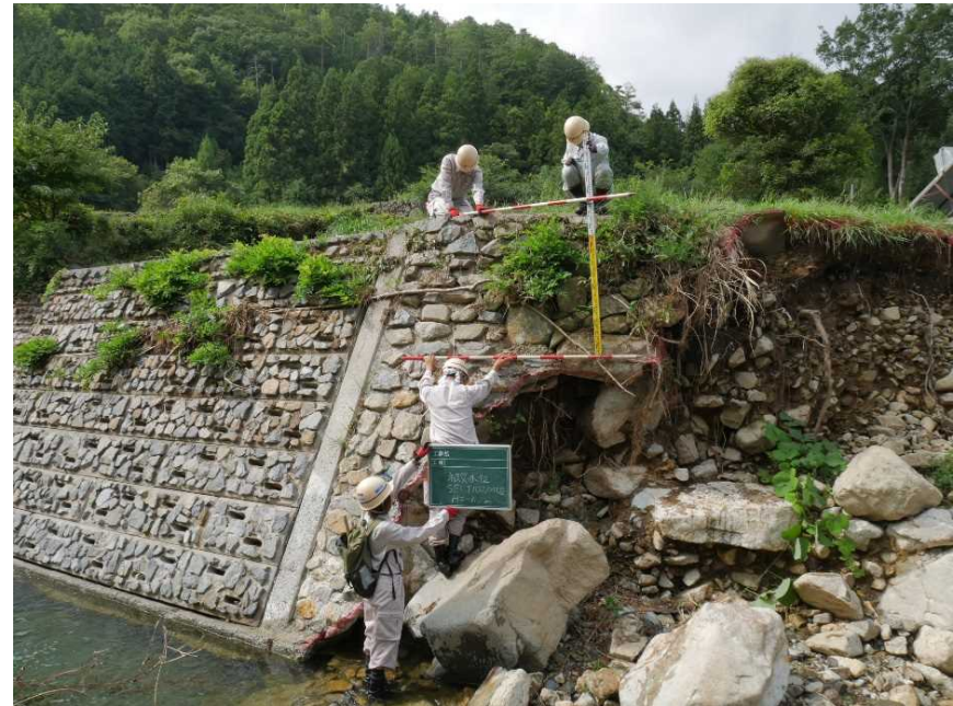
被災現場での測量技術者達 (広島)
