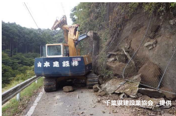
千葉県建設業協会会員による道路啓開 (台風19号 千葉県大多喜町)
