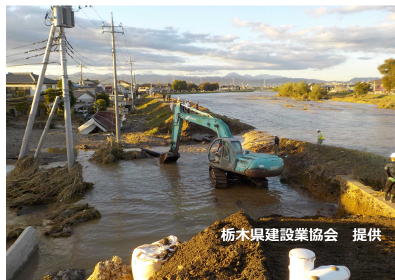
栃木県建設業協会会員による河川堤防緊急応急 (台風19号 栃木県佐野市)
