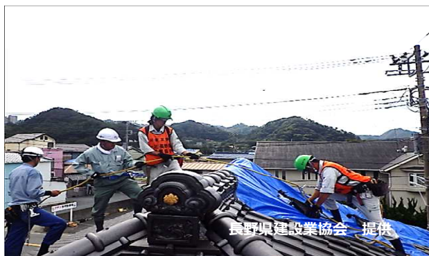
長野県建設業協会会員による屋根ブルーシート張り (台風15号 千葉県鋸南町)
