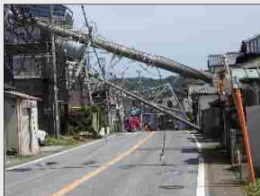
< 令和元年台風 15 号による被害 >
