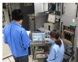
(航空保安施設点検実施状況)
