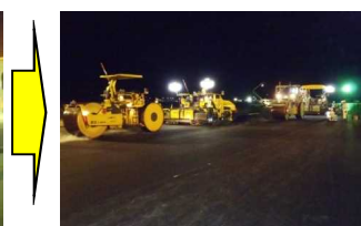
(老朽化した滑走路舗装の改良)
