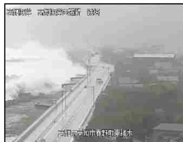
平成30年9月30日 戸原工区
