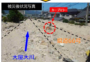
土砂・洪水氾濫による被害(H30.7豪雨)
