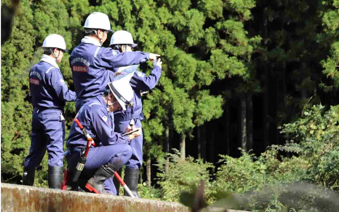
土砂災害の現地調査を進める被災状況調査班【令和元年台風第19号:神奈川県南足柄市】
