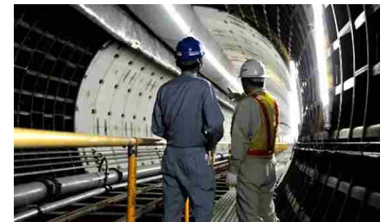
雨水貯留管の整備
