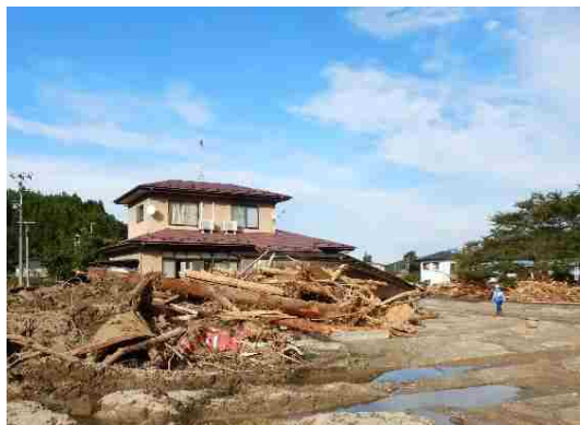
土砂・洪水氾濫による被害 いぐんまるもりまち (宮城県伊具郡丸森町)
