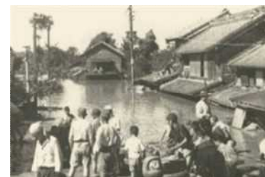
氾濫状況(埼玉県久喜市)
