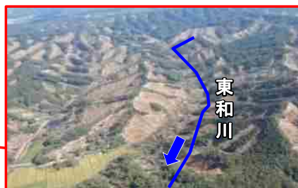
山腹崩壊発生状況
