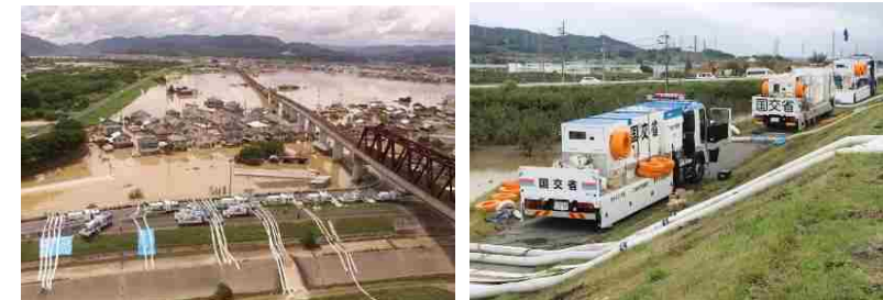
【H30.7月豪雨】 (岡山県倉敷市真備町)
