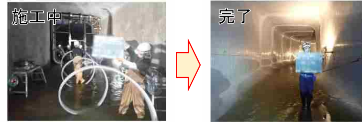
管更生による 管きよの耐震対策 (東京都)
