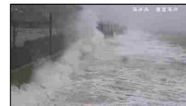
平成30年台風21号 塩屋工区
