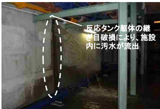
処理場の被災事例(漏水)
