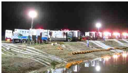
排水ポンプ車による24時間体制の緊急排水 【令和元年8月前線に伴う大雨:佐賀県大町町】
