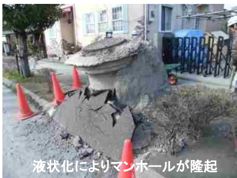
管路の被災事例
