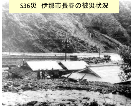
S36災 伊那市長谷の被災状況
