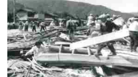
昭和36年洪水 かみしむら 旧上志比村の被災状況
