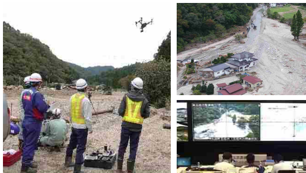
ドローンによる被災状況調査と衛星回線を用いたリアルタイム映像配信 【R元.10 台風第19号】(宮城県丸森町)
