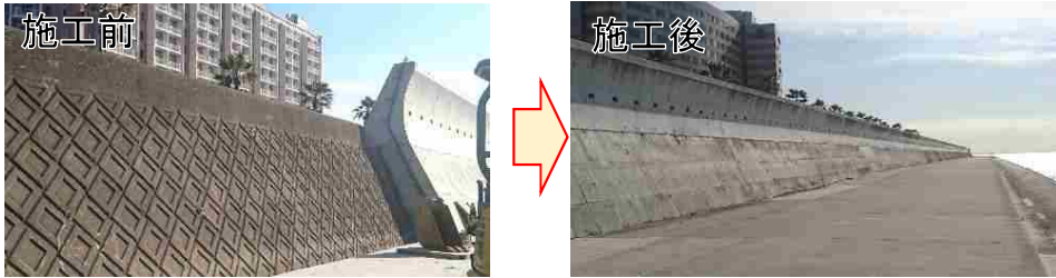
堤防のかさ上げ（千葉県浦安海岸）
