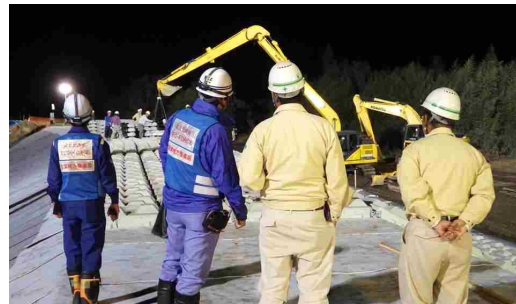
堤防の早期復旧に向け協力企業と連携 【令和元年台風第19号:埼玉県東松山市】
