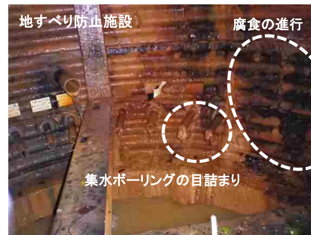
排水機能の低下・集水井の主要部材の腐食
