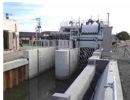
雨水ポンプ場の整備
