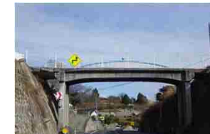
< 地方管理の跨道橋（未対策） >
