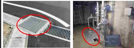
<排水施設> <排水ポンプ>
