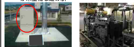
<無停電装置> <自家発電装置>
