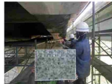
修繕の様子(断面修復)
