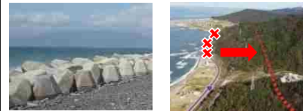
<消波・根固ブロック> <ネットワーク整備>
