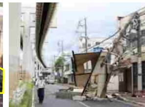
< 台風15号による 電柱倒壊状況 >
