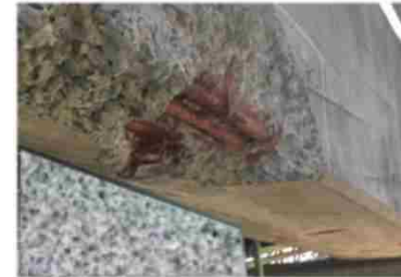
損傷状況(鉄筋露出)
