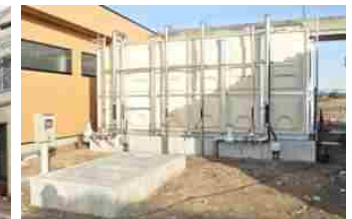
< 道の駅の防災機能強化 (貯水タンク整備) >
