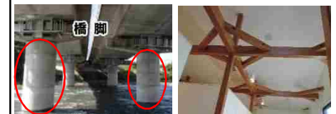
<橋梁の耐震対策> <道の駅の耐震対策>
