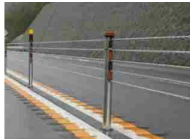
<ワイヤロープの設置事例>
