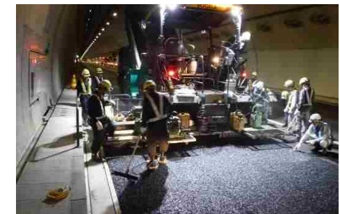
<トンネル部の施工状況>
