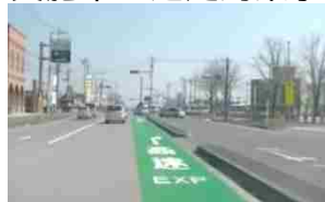
一般道から高速道路インターチェンジへの誤進入を防ぐカラー舗装
