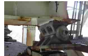
< 橋梁の支承・主桁の損傷 >
