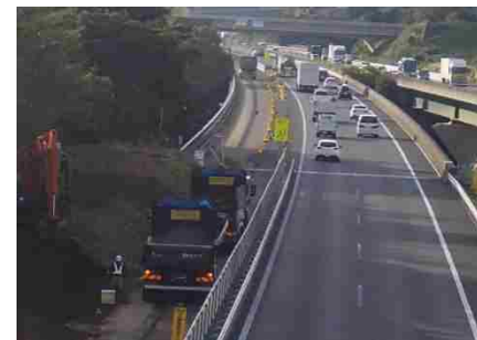
<土工・橋梁部の施工状況>
