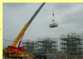
クレーンで設置
