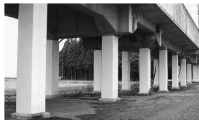
高架橋の耐震対策の例
