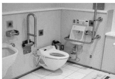
障害者対応型トイレ
