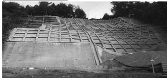
コンクリート枠による斜面の補強
