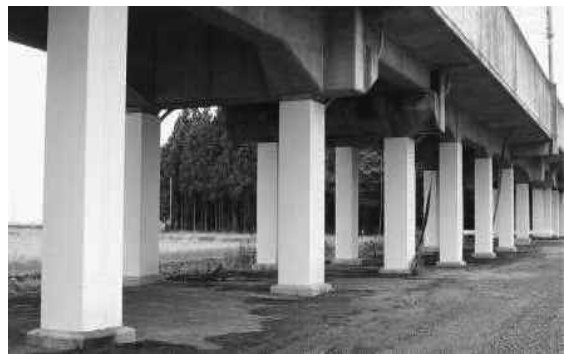
鋼板巻きによる高架橋の耐震補強
