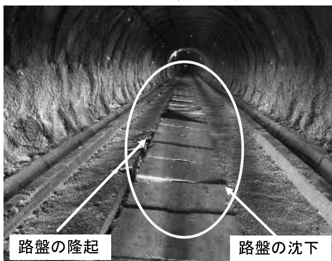
トンネル（先進導坑）の変状
