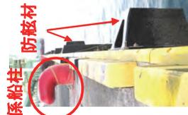
大型クルーズ船の係留に対応した係船柱※1・防舷材※2の設置。
