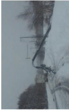
暴風雪による電柱の倒壊
