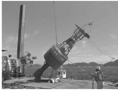
灯浮標の設置
