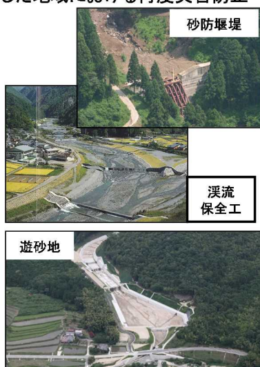
【令和2年7月豪雨】砂防堰堤が土砂と流木を捕捉
