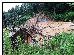
【令和2年7月豪雨】砂防堰堤が土砂と流木を捕捉
