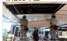
天井板の耐震改修
