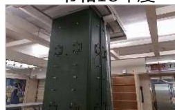
柱の耐震改修
