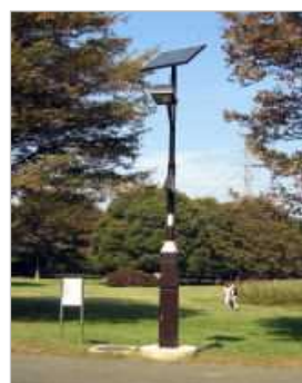
ソーラーパネル付き照明灯 (東京都小金井市)
