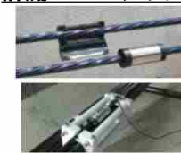
センサーを利用した 橋梁ケーブル張力の モニタリング
