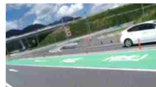
高速道路出入口部における対策 (カラー舗装)
