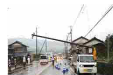
沿道の電柱の倒壊による道路閉塞
