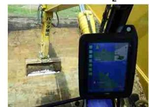
道路の新設工事におけるICT建設機械での切土法面の掘削状況
