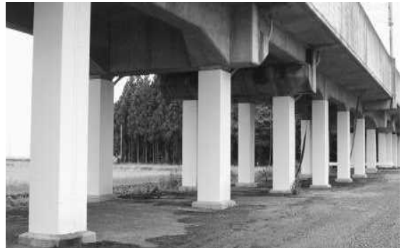
鋼板巻きによる高架橋の耐震対策
