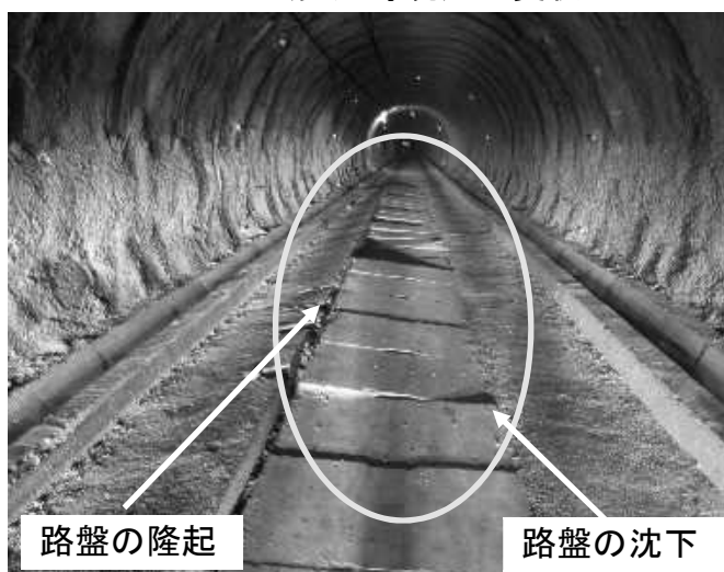
トンネル（先進導坑）の変状
