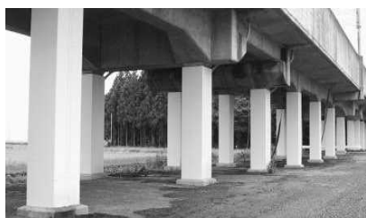
鋼板巻きによる高架橋の耐震対策
