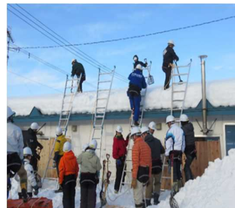
雪下ろし実技講習
