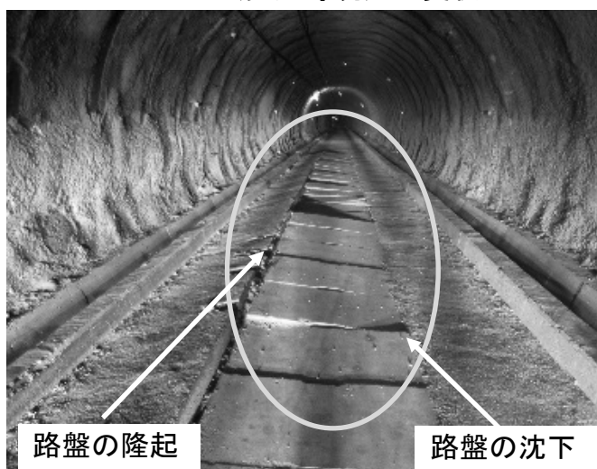
トンネル（先進導坑）の変状
