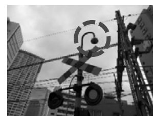
踏切監視用カメラ
