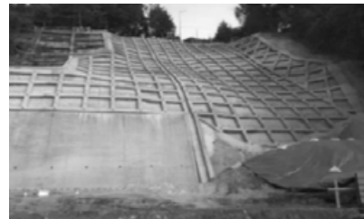
斜面の補強
