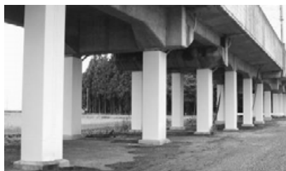
鋼板巻きによる高架橋の耐震対策
