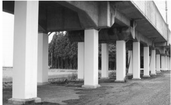
鋼板巻きによる高架橋の耐震対策
