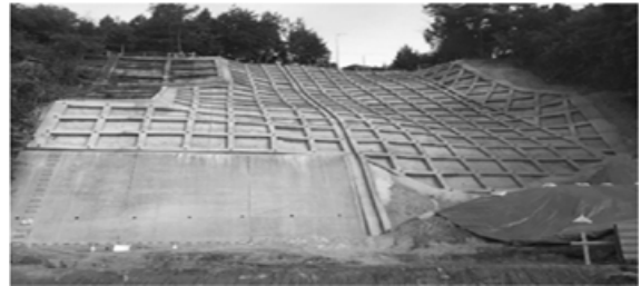
コンクリート枠による斜面の補強
