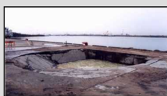
内部の鉄筋が露出した橋梁 陥没した港湾施設のエプロン部
