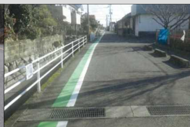
区画線の設置・カラー舗装
