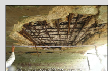
内部の鉄筋が露出した橋梁 陥没した港湾施設のエプロン部
