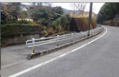
防護柵の設置
