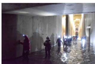
内部見学ツアー（首都圏外郭放水路）
