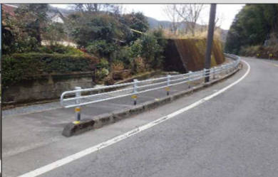
防護柵の設置
