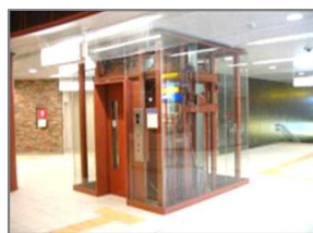
エレベーター
