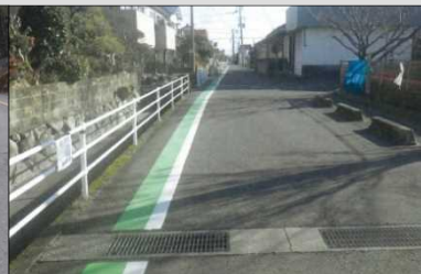
区画線の設置・カラー舗装
