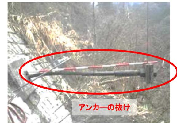
アンカー工の損傷・変形
