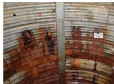
経年の結果、粘性物質により目詰まりした従来型の集水管
