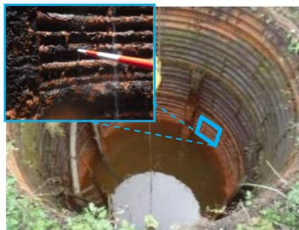
老朽化により内壁の腐食が進行
