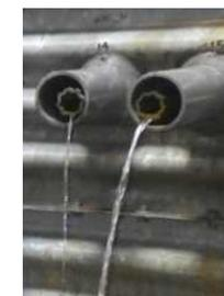
波形集水管が採用された集水井内部
