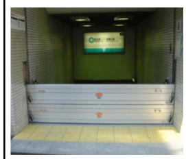
止水板の整備
