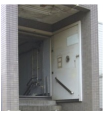
防水扉の整備
