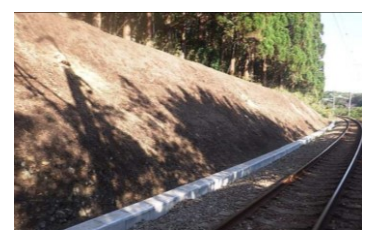
鉄道隣接斜面の補強
