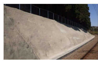
鉄道隣接斜面の補強
