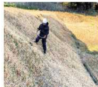
急傾斜法面での草刈り作業
