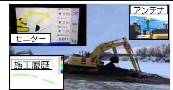
ICT建設機械を活用した掘削
