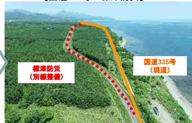
【国道335号 標津防災】
