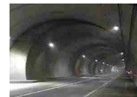
国道230号三豊トンネル(洞爺湖町)
