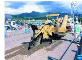
トレンチャー機械による掘削の試験施工 (国道5号 赤松街道電線共同溝)
