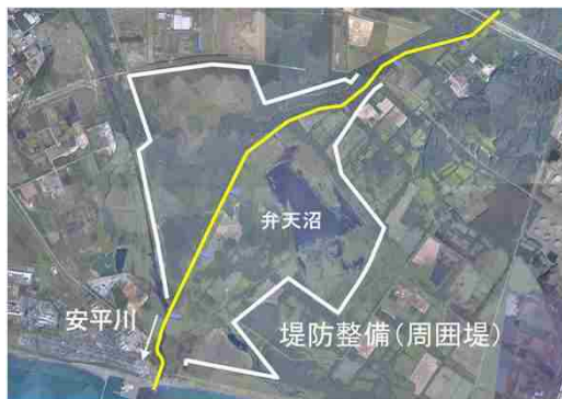
安平川水系安平川 (苫小牧市) (河道内調整地)
