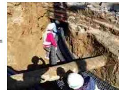
(角型多条電線管の整備事例) ※支障物件をかわすことが可能
