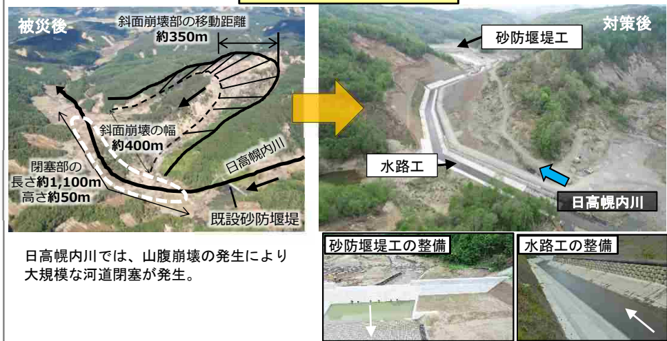
日高幌内川における対策工
