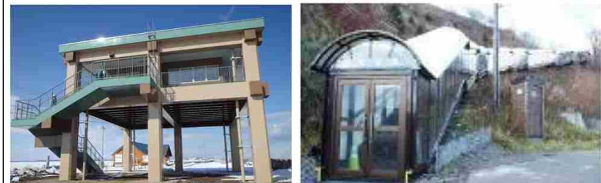
津波避難タワーの整備 (積雪寒冷を考慮した防寒機能付)
