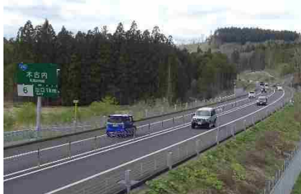
函館・江差自動車道 茂辺地木古内道路(R4.3開通)
