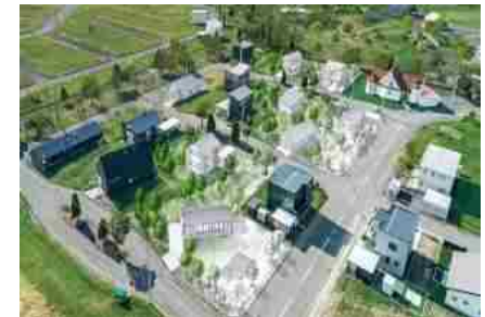
北方型住宅の建設が進む分譲地(南幌町)
