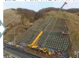
【国道232号 苫前町力屋地区法面対策】
