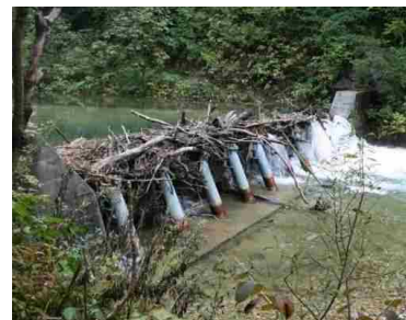
〈流木捕捉機能を持った治山ダム〉
