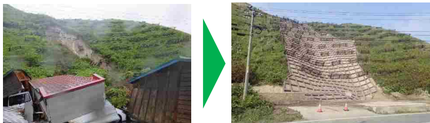
〈斜面の安定を図る山腹工〉
