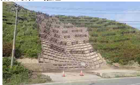
斜面の安定を図る山腹工
