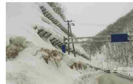
道路斜面における雪崩予防柵設置
