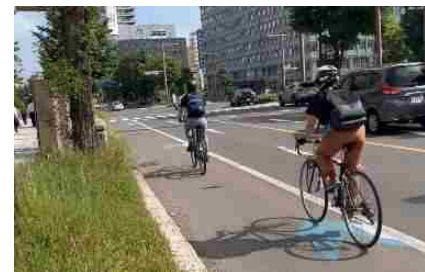
自転車の通行位置を示す矢羽根型路面表示の設置例 国道230号(札幌市)
