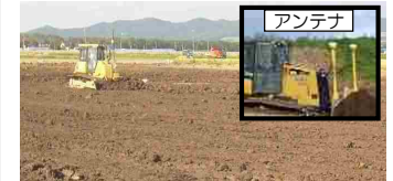
GNSSを活用した整地
