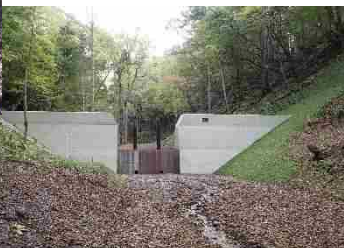
〈土砂流出を抑制し山地災害を防ぐ治山ダム〉
