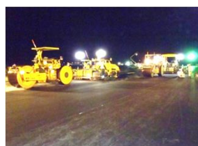
(老朽化した滑走路舗装の改良)
