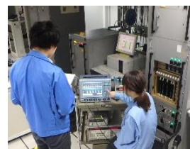
(航空保安施設点検実施状況)
