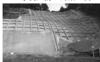
斜面の補強
