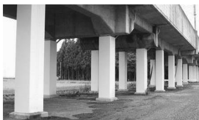
鋼板巻きによる高架橋の耐震対策
