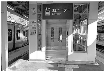
エレベーター
