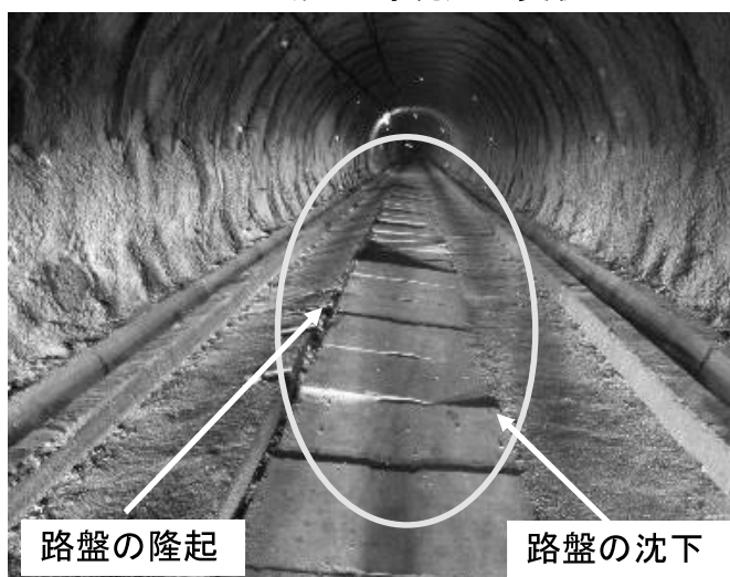
トンネル（先進導坑）の変状
