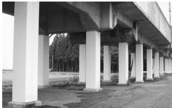
鋼板巻きによる高架橋の耐震対策
