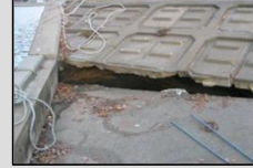
建設後50年以上経過する社会資本の割合 内部の鉄筋が露出した橋梁 陥没した港湾施設のエプロン部分 クラックが生じた河川護岸 地方公共団体の技術職員数
