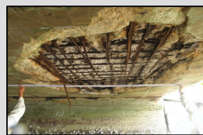
建設後50年以上経過する社会資本の割合 内部の鉄筋が露出した橋梁 陥没した港湾施設のエプロン部分 クラックが生じた河川護岸 地方公共団体の技術職員数
