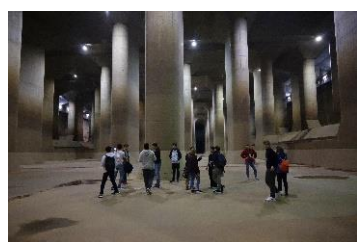
インフラツーリズム （首都圏外郭放水路）
