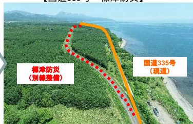
【国道335号 標津防災】
