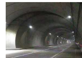
国道230号三豊トンネル(洞爺湖町)
