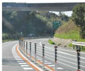
寒地土木研究所の研究成果を活用したワイヤロープ式防護柵
