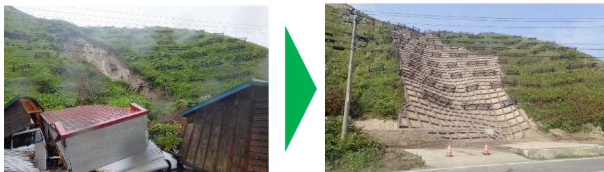
〈斜面の安定を図る山腹工〉
