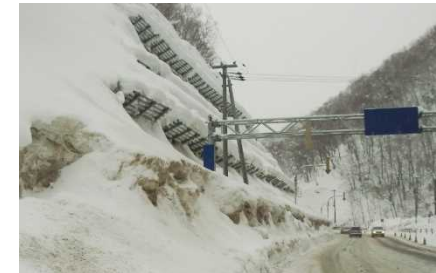
道路斜面における雪崩予防柵設置
