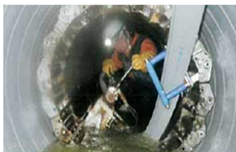
下水管路の耐震化
