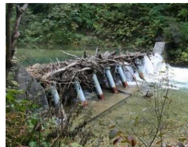
〈流木捕捉機能を持った治山ダム〉
