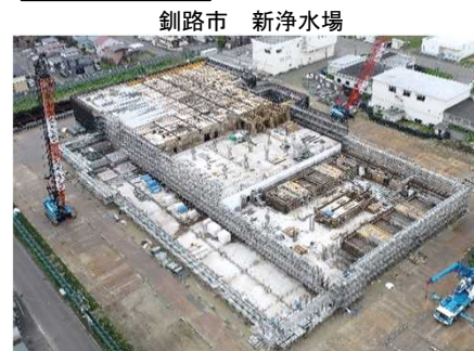
釧路市 新浄水場
