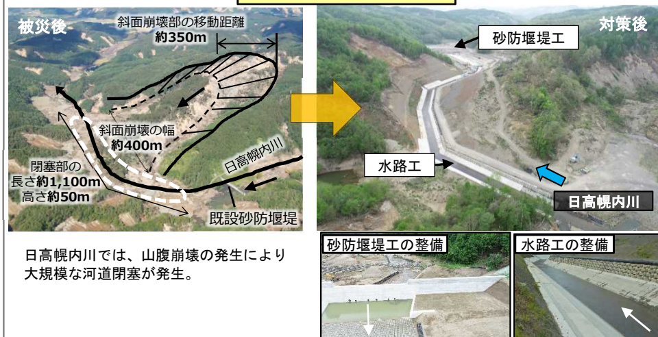
日高幌内川における対策工
