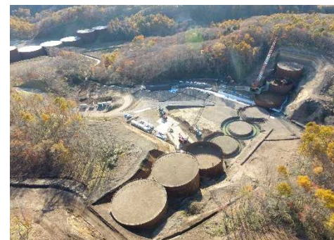
くまのさわ 樽前山熊ノ沢川3号砂防堰堤（苫小牧市）
