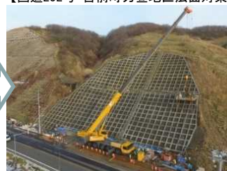
【国道232号 苫前町力屋地区法面対策】
