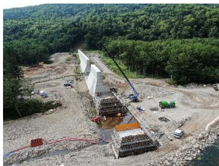
とったべつ 十勝川水系戸蔭別川第4号砂防堰堤（帯広市）
