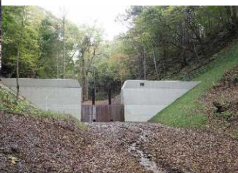
〈土砂流出を抑制し山地災害を防ぐ治山ダム〉
