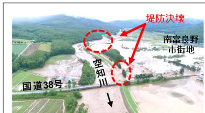
空知川の被災状況
