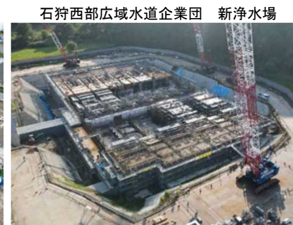
石狩西部広域水道企業団 新浄水場
