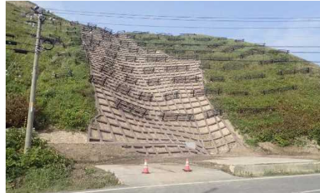
斜面の安定を図る山腹工
