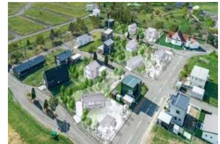
北方型住宅の建設が進む分譲地(南幌町)
