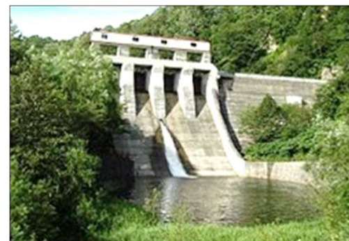
雨竜川ダム再生事業 (雨竜第2ダム(幌加内町))
