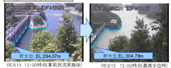
蓮ダム貯水位状況
