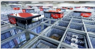
自動倉庫型ピッキングシステム
