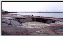
建設後50年以上経過する社会資本の割合 内部の鉄筋が露出した橋梁 陥没した港湾施設のエプロン部分 クラックが生じた河川護岸 地方公共団体の技術職員数
