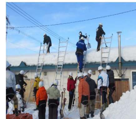
雪下ろし実技講習
