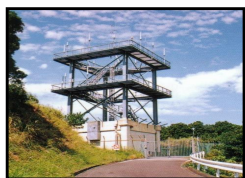
遠隔対空通信施設
