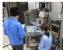
(航空保安施設点検実施状況)
