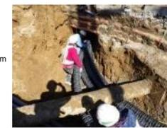
(角形多条電線管の整備事例) ※支障物件をかわすことが可能
