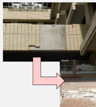
外壁落下による事故発生のおそれがあり、外壁改修が必要
