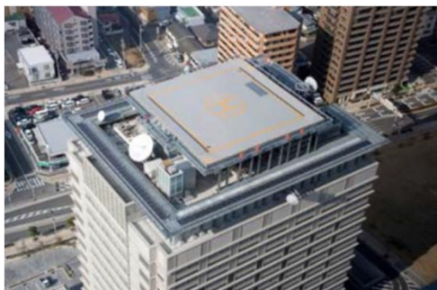
屋上ヘリポート
