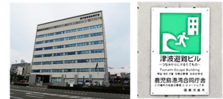
(鹿児島港湾合同庁舎)津波避難ビルの機能を確保
