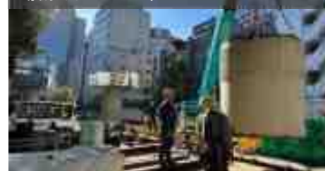
現在の工事状況（江戸橋出口橋脚撤去） （撮影日：R5.8.3）
