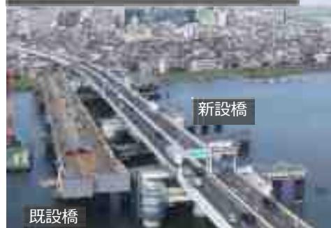
②新設橋設置後（撮影日：R5.9.27）
