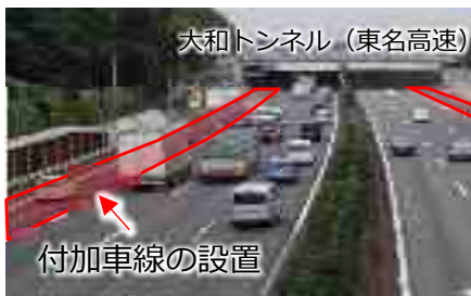
ボトルネック対策 (付加車線の設置)
