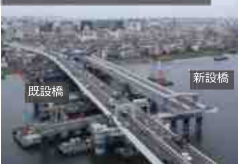
①新設橋設置前（撮影日：R5.5.26）
