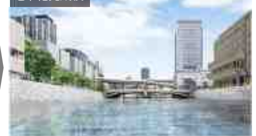
地下化完成後
