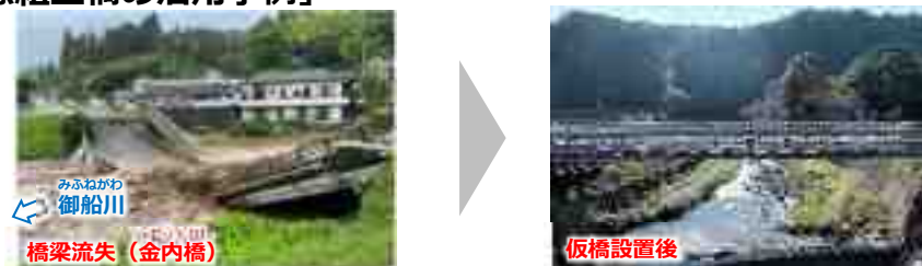
令和5年7月梅雨前線の大雨（国道445号（金内橋）：熊本県）
