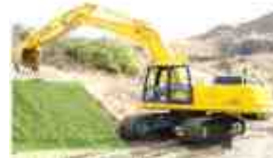
ICT施工の活用
