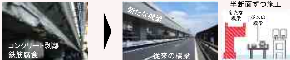
構造物全体の架け替えを実施
