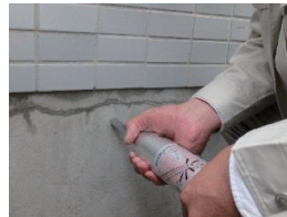
コンクリートの 圧縮強度の測定
