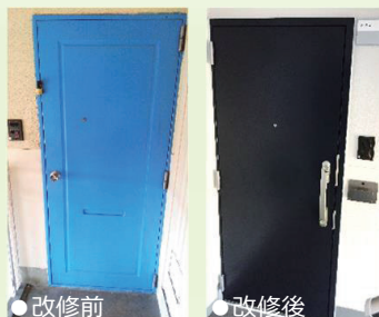
●改修前 ●改修後
