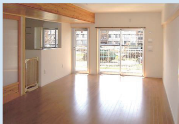
衝撃吸収性のあるフローリングへの改修
