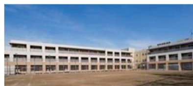
学校を改修して整備した住宅
