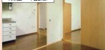
段差への配慮
