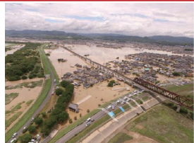
平成30年7月豪雨（倉敷市真備町）
