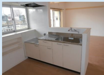
見守りができる対面キッチンへの改修
