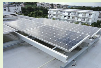
太陽光発電関連設備の設置
