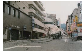
建物倒壊による道路閉塞
