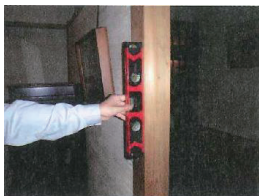
水平器による 柱の傾きの計測
