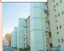
エレベータ設置
