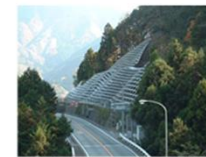
斜面崩落防止対策
