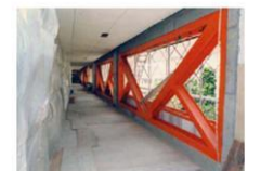
鉄骨ブレースによる壁の補強
