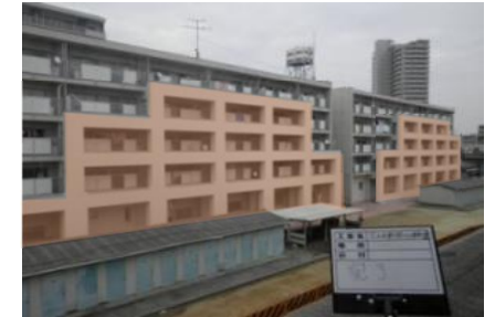
▲外付けフレーム耐震補強
