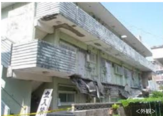
建物の傷みが著しく外壁の剥落、鉄骨の露出などが見られる事例
