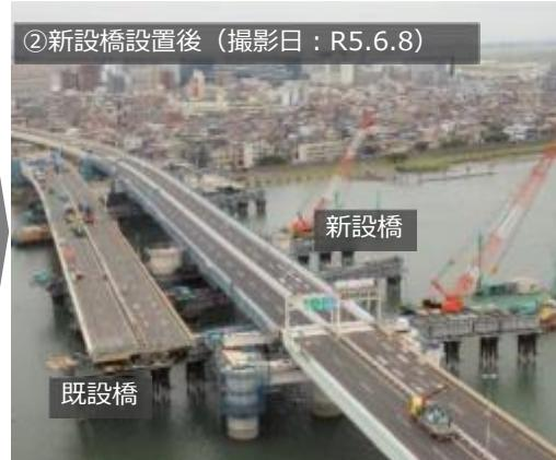
延長約300mの新設橋を既設橋の位置へ移動して架設
